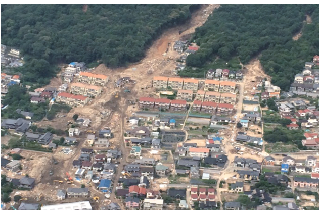
平成26年広島県広島市の土砂災害の被災現場 (内閣府提供)
